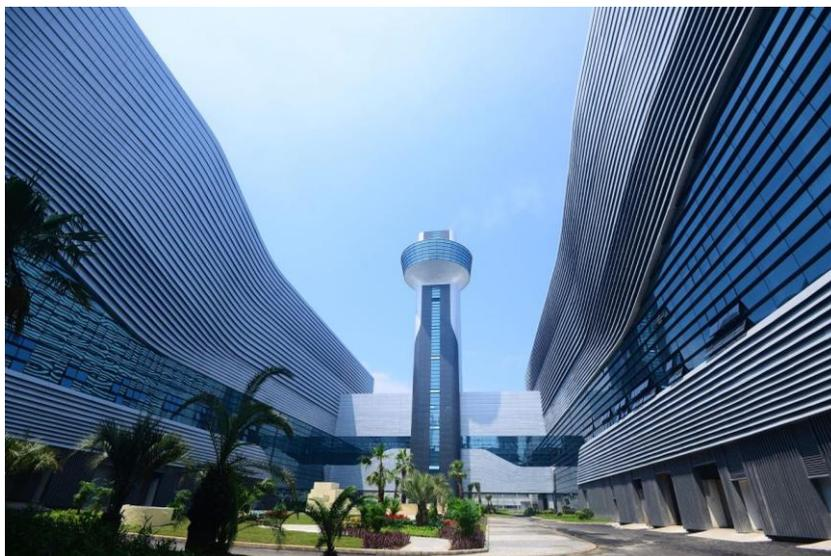
老港再生能源利用中心是上海市生活垃圾全程分类体系重要的末端处置设施建设项目。目前，老港再生能源利用中心共有 12 台 750 吨/日的焚烧线，2 台 30 兆瓦及 3 台 50 兆瓦的汽轮发电机组，每日消纳上海市中心城区生活垃圾 11000 余吨，占全市生活垃圾产生量的近 1/3，已成为全世界单体处置规模最大的生活垃圾焚烧发电厂，是支撑老港生态环保基地打造“上海固废百年处置基地”的核
